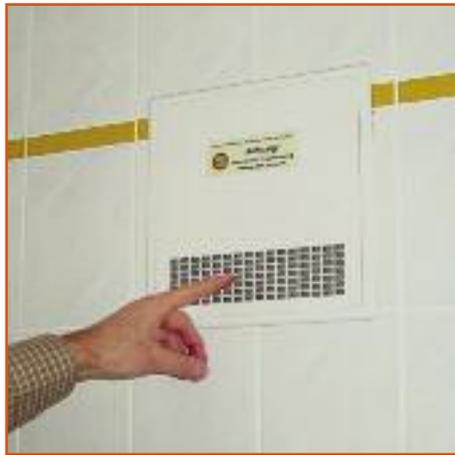
**Im Bad und WC Filter reinigen: Rahmen abnehmen - Filter raus und waschen oder ersetzen.**
